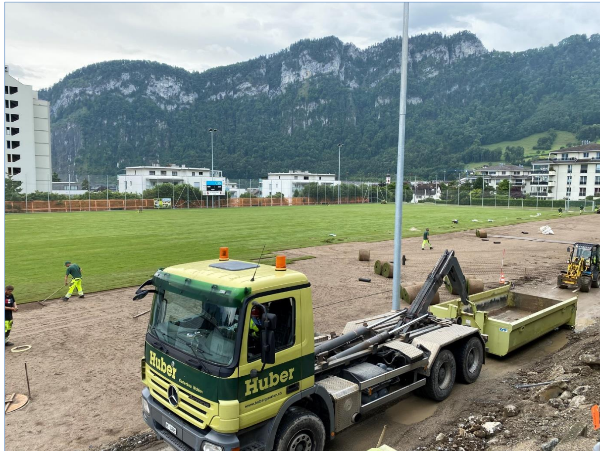
Verlegen Rasensoden 4. Juni 2025
