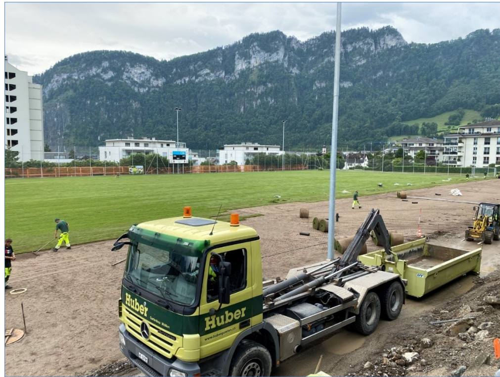
Verlegen Rasensoden 4. Juni 2025
