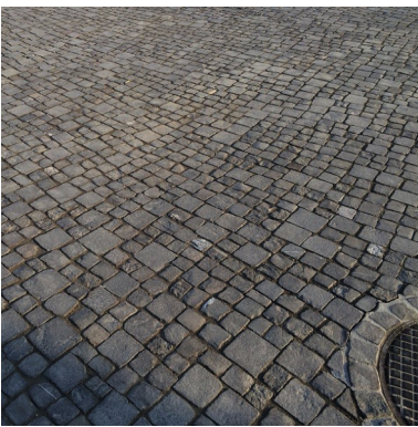
Vorplatz mit Plästerung sickerfähig
