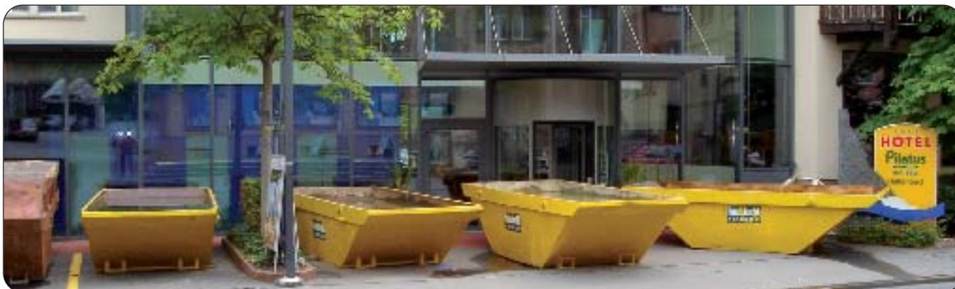
8 Gefüllte Mulden beschweren und wirken gegen den Wasserdruck von unten.
