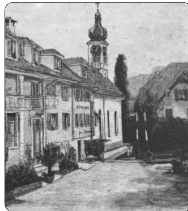
Altes Hotel Krone mit Bahn-Barriere.
